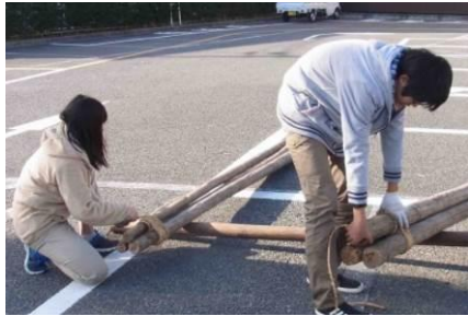
丸太を「水に浸した荒縄」で結んで、三角錐を2つ重ねます
