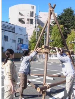
丸太を「水に浸した荒縄」で結んで、三角錐を2つ重ねます
